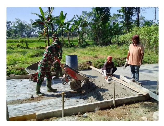
Bertepatan di lokasi Betonisasi jalan penghubung antara Jurang Gunting RT 02 RW 05 dan Krasak RT 02 RW 06 dengan lebar 3 meter, Panjang 325 meter, dalam proses pengerjaanya TNI dibantu warga setempat yang saling kerjasama saat pengerjaan Betonisasi jalan penghubung tersebut.
